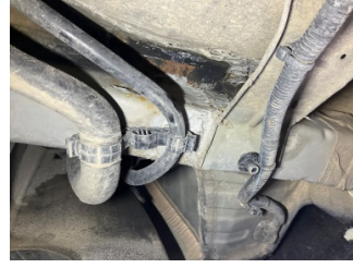
Kaporta, Sağ Arka Şase > Standart Dışı Onarım
