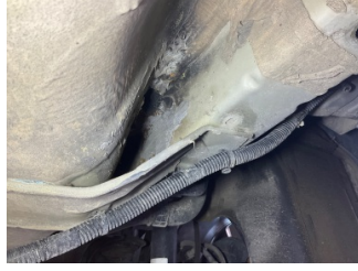
Kaporta, Sağ Arka Şase > Standart Dışı Onarım
