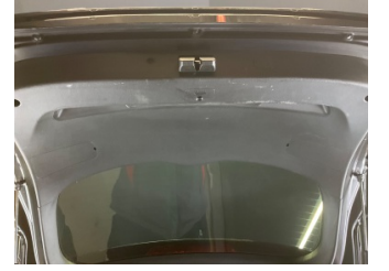
Döşemeler/Kapaklar, Döşemeler/Kapaklar > Deforme Olmuş
